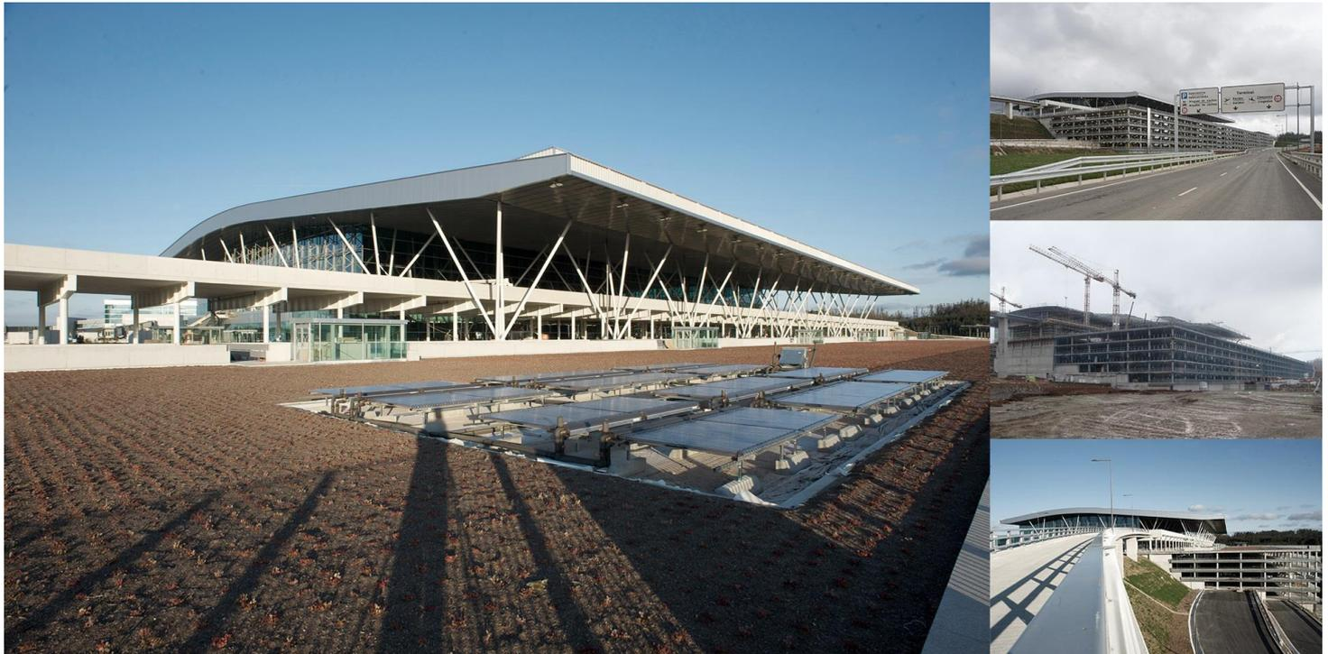
El Edificio Aparcamiento de la Terminal del Aeropuerto de Santiago tiene dimensiones en planta de 325.50 m x 92.10 m. Se trata de un edificio semienterrado para vehículos, con 5 sótanos más un nivel inferior destinado a las instalaciones. Las luces entre pilares varían de una dirección a otra. Sobre el eje Y, dicha luz es de 8,00 m u 8,33 m, y sobre el eje X la luz es de 8,33 m.
